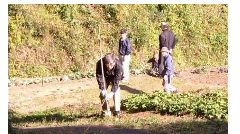
縄張り(測量)の様子
