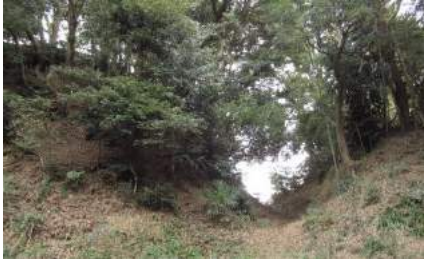
焰硝蔵の保全で堀切りもくっきり
